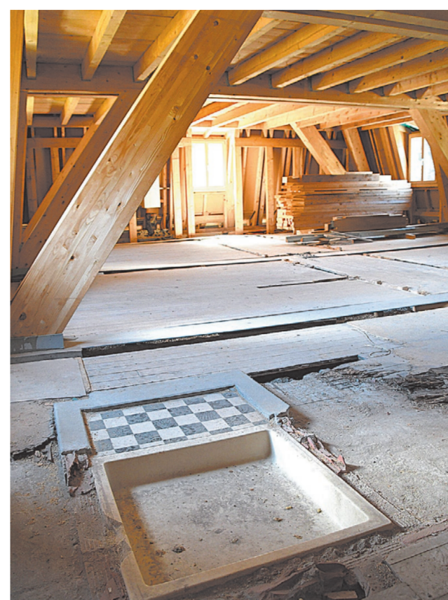
Im Vordergrund die Überreste einer alten Dusche, im Hintergrund der neue Dachstuhl, aufgerichtet von Vögeli Holzbau AG.
