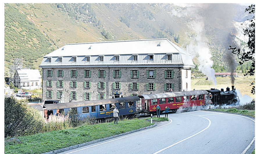
Die Dampfbahn der Furka-Bergstrecke passiert das Blaue Haus. Dach und Dachstuhl, Fenster und Fensterläden sind bereits vollständig saniert.
