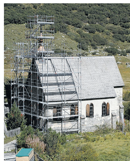
Ebenfalls eingerüstet: das Türmchen der anglikanischen Kapelle.
