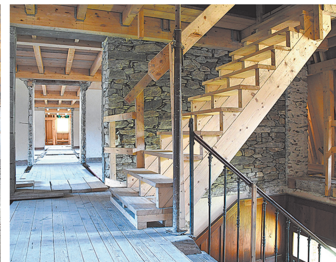
Blick ins teilweise erneuerte Mansardengeschoss. Die Bautreppe rechts führt in den Estrich hinauf, dahinter ist die mit einheimischen Granitsteinen neu aufgebaute Brandmauer zu erkennen.
